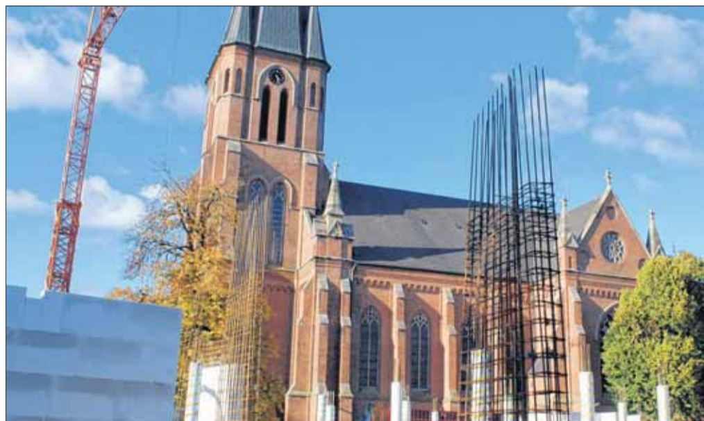
Voll im Zeitplan im Schatten des „langen Antons“ ist der Bau des Arkadenhauses. Assies-Foto
